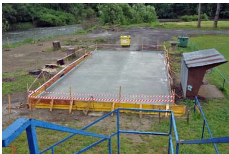
Betónová doska – základ pre budúci altánok.
